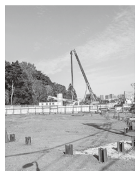
工事が進む「林試の森公園」
